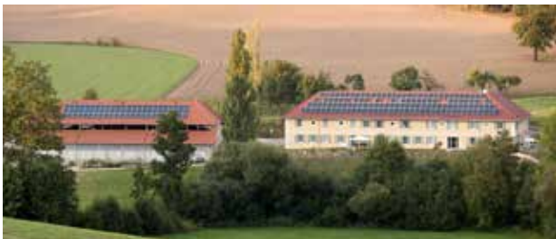
Contracting Anlagen von Diakonie und Fam. Landl
