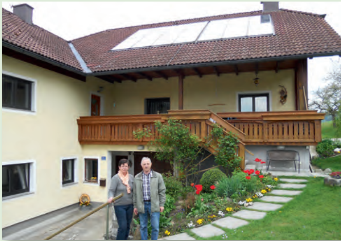
Solaranlage Maurer/Maierhofer, Stratreith Baujahr 1996
